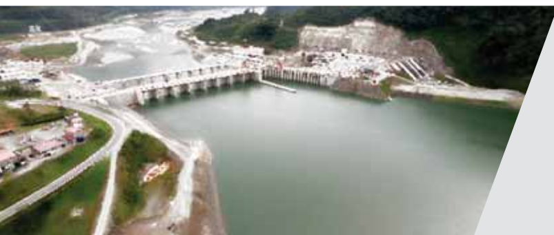
Fiscalización de la Construcción de Obras Civiles, Montaje de Equipos y Puesta en Marcha del Proyecto Hidroeléctrico Coca Codo Sinclair (1500 MW)
