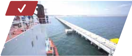
Muelle de GLP en Monteverde.
