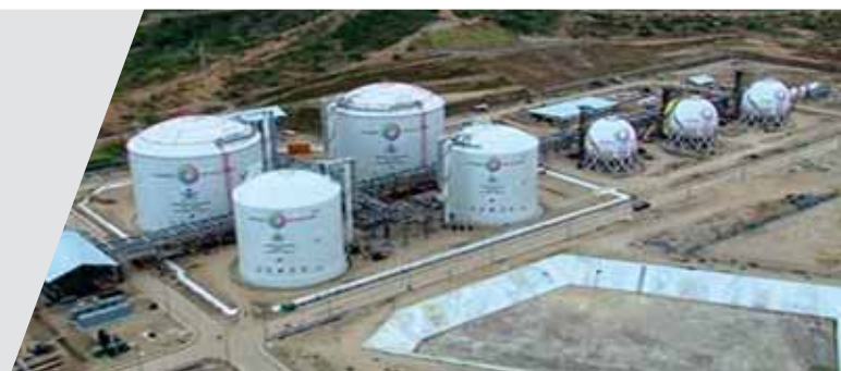
Estudios Geotécnicos, Diseños de Cimentación y Estudios de Riesgo Sísmico Muelle de GLP Monteverde
